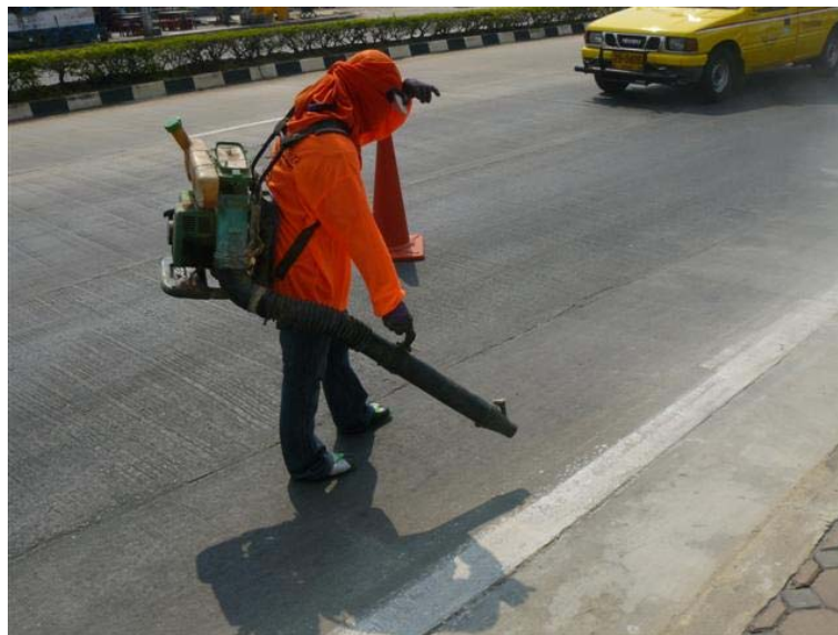
ภาพที่ 33 ภาพแสดงการใช้เครื่องเป่าลม ทำความสะอาด
