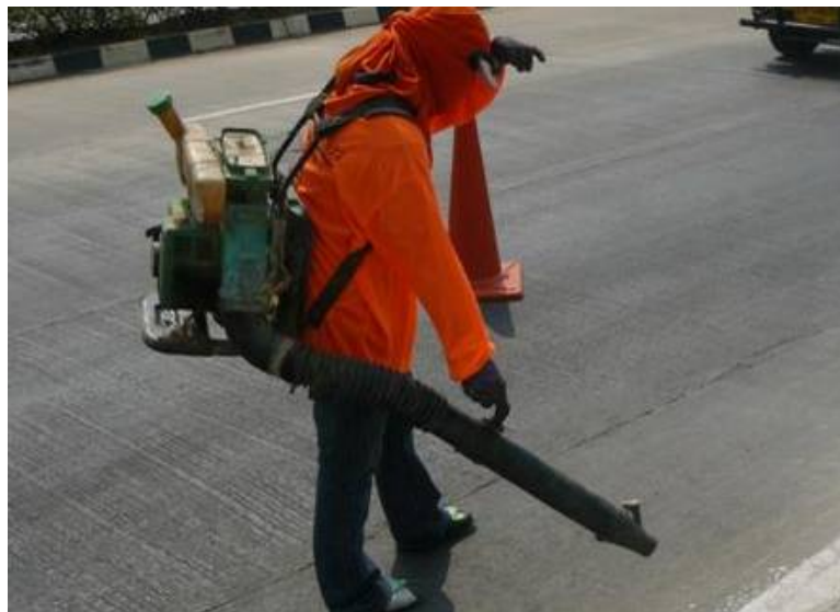
ภาพที่ 25 เครื่องเป่าฝุ่น ใช้ทำความสะอาดก่อนพ่นน้ำยา Primer
