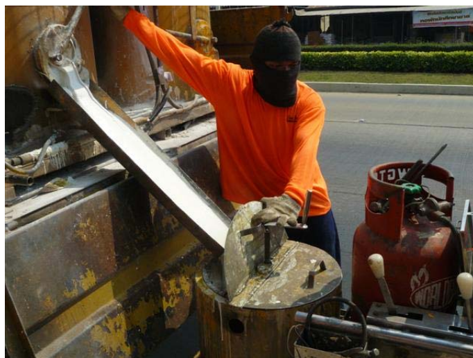
ภาพที่ 35 ภาพแสดงการนำวัสดุเทอร์โมพลาสติกหลอมเหลว เทใส่ในเครื่องตีเส้นจราจร
