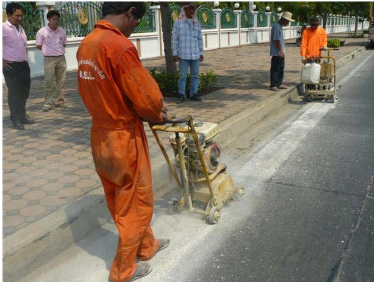
ภาพที่ 31 ภาพแสดงการใช้เครื่องจักรกลลบเครื่องหมายจราจรบนผิวทาง (แบบหยาบและละเอียด)
