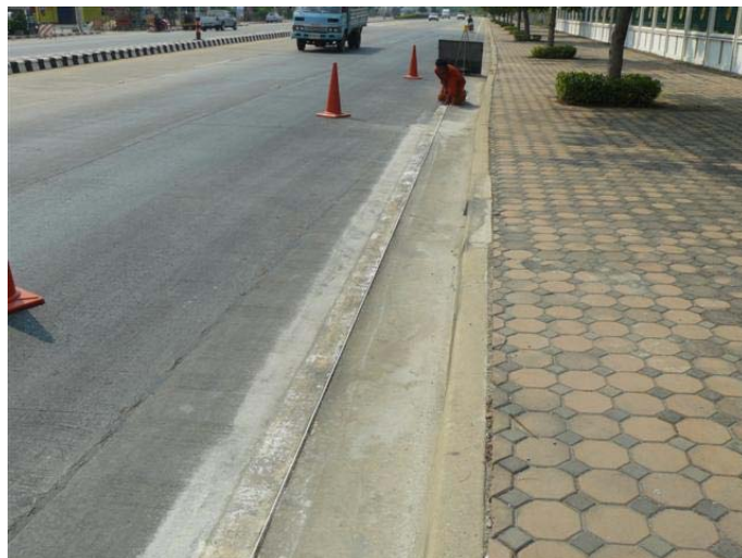
ภาพที่ 37 ภาพแสดงการวางแนวเพื่อที่จะตีเส้นจราจร
