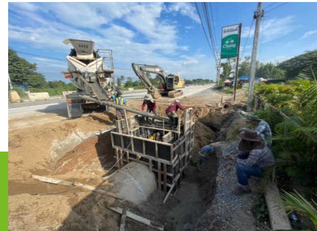
ภาพการก่อสร้าง1
