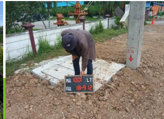
ภาพการก่อสร้าง2
