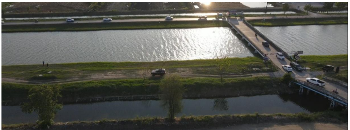
รูปที่ ๑๔ แสดงสภาพคันคลองประปาเดิม ซึ่งมีท่อประปาขนาดเส้นผ่านศูนย์กลาง ๑,๕๐๐ มิลลิเมตร วางขนานกับคลองประปามหาสวัสดิ์ และอยู่บนถนน Service Road No.๔ ตามแบบคู่สัญญา
